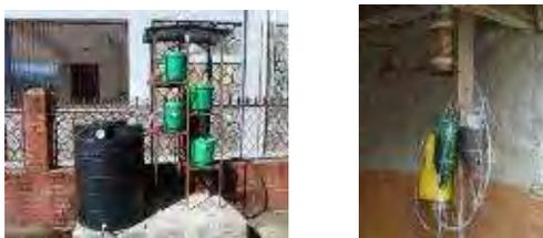
図1. 簡易砂濾過装置の実例
